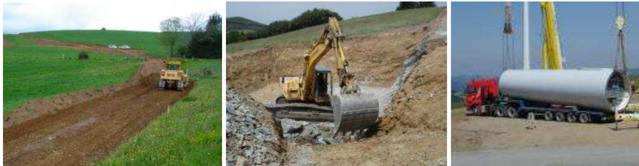
Photographie 42 : illustration d'un chantier éolien
