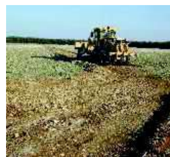
Décapage pour câblage
