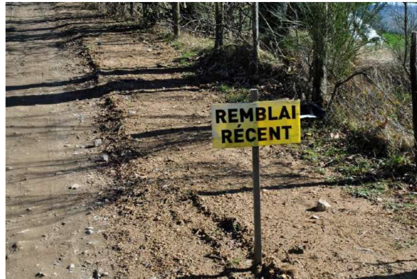
Photographie 40 : Exemple de remblai des tranchées électriques le long d'une piste
