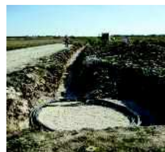
Pose de réseaux HTA
