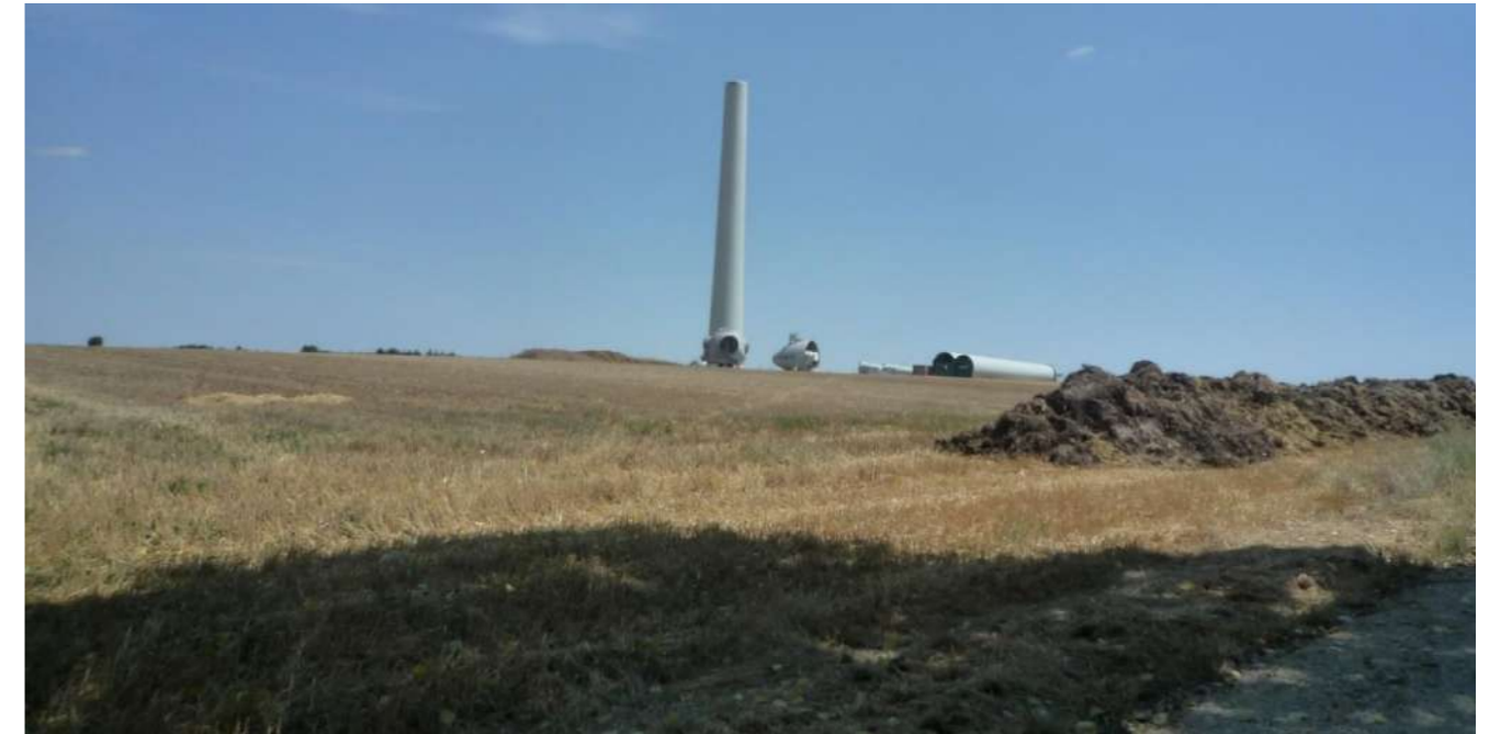
Photographie 39 : Exemple de stockage de terre durant un chantier éolien
